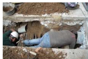
14 Rasa 1 excavació manual rasa.JPG
