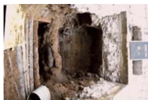
18 Rasa 1 Detall col·lector u.e. 110.JPG
