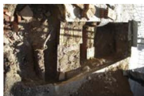
26 Rasa 2 protecció serveis moderns.JPG
