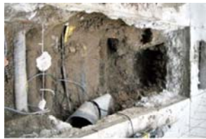
07 Rasa 1 Serveis afectats.JPG
