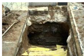
28 Rasa 2 Detall col·lector u.e. 207.JPG
