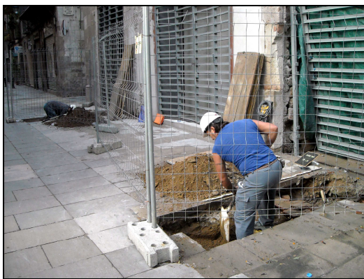
A l'esquerra vista del procés d'excavació de la rasa. A la dreta vista dels diferents serveis
