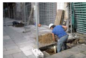
20 Rasa 2 Inici excavació manual.JPG
