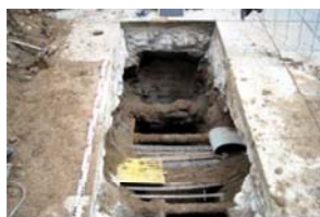
17 Rasa 1 Detall col·lector u.e. 110.JPG
