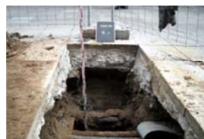
19 Rasa 1 Detall col·lector u.e. 110.JPG
