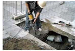
05 Rasa 1 afectació serveis moderns.JPG
