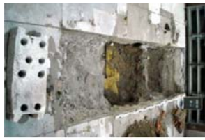
02 Rasa 1 Inici excavació.JPG
