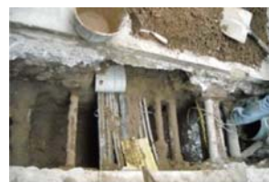
15 Rasa 1 Vista general des del Sud.JPG
